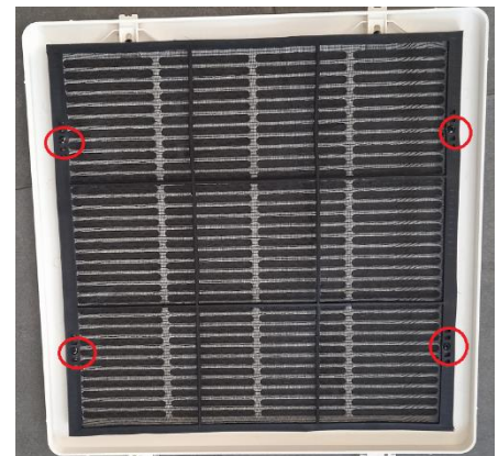
αφαίρεση φίλτρου γρίλιας
